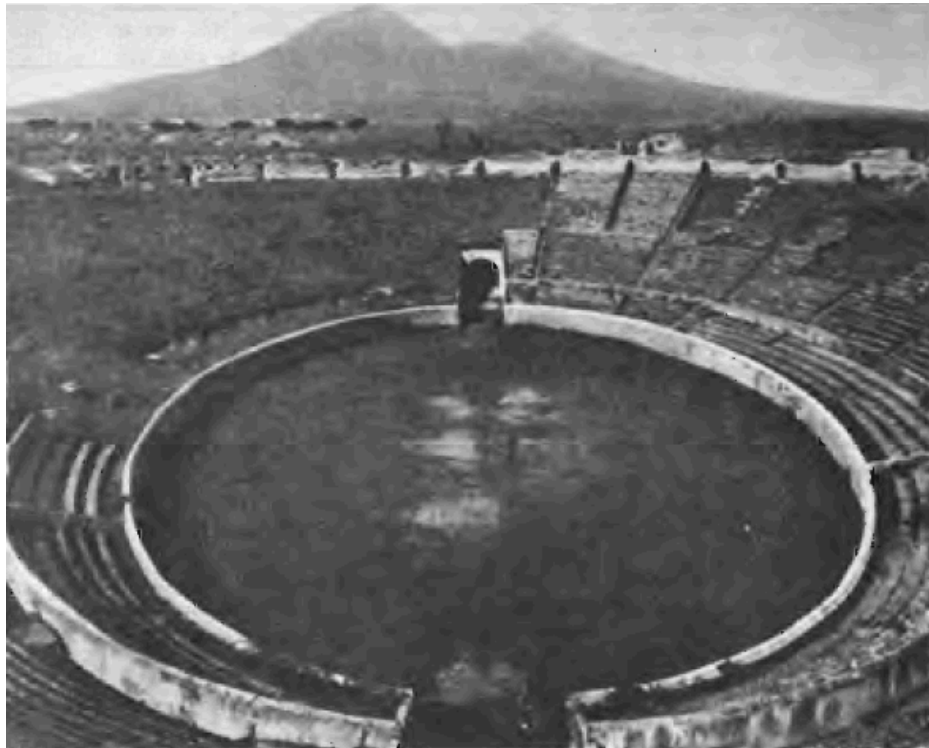
GRAV. 43 — O anfiteatro de Pompéia é o mais antigo dos" anfiteatros romanos conservados. Construído em 80 antes de J. C, cavado na terra, tinha 35 fileiras de assentos para 20.000 espectadores. Um imenso toldo protegia a arena e o público.
