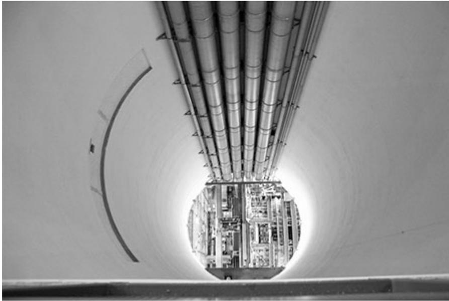
*Figura 29. Vista do poço do ATLAS a partir da plataforma superior, mostrando os tubos que transportavam materiais para baixo.*
