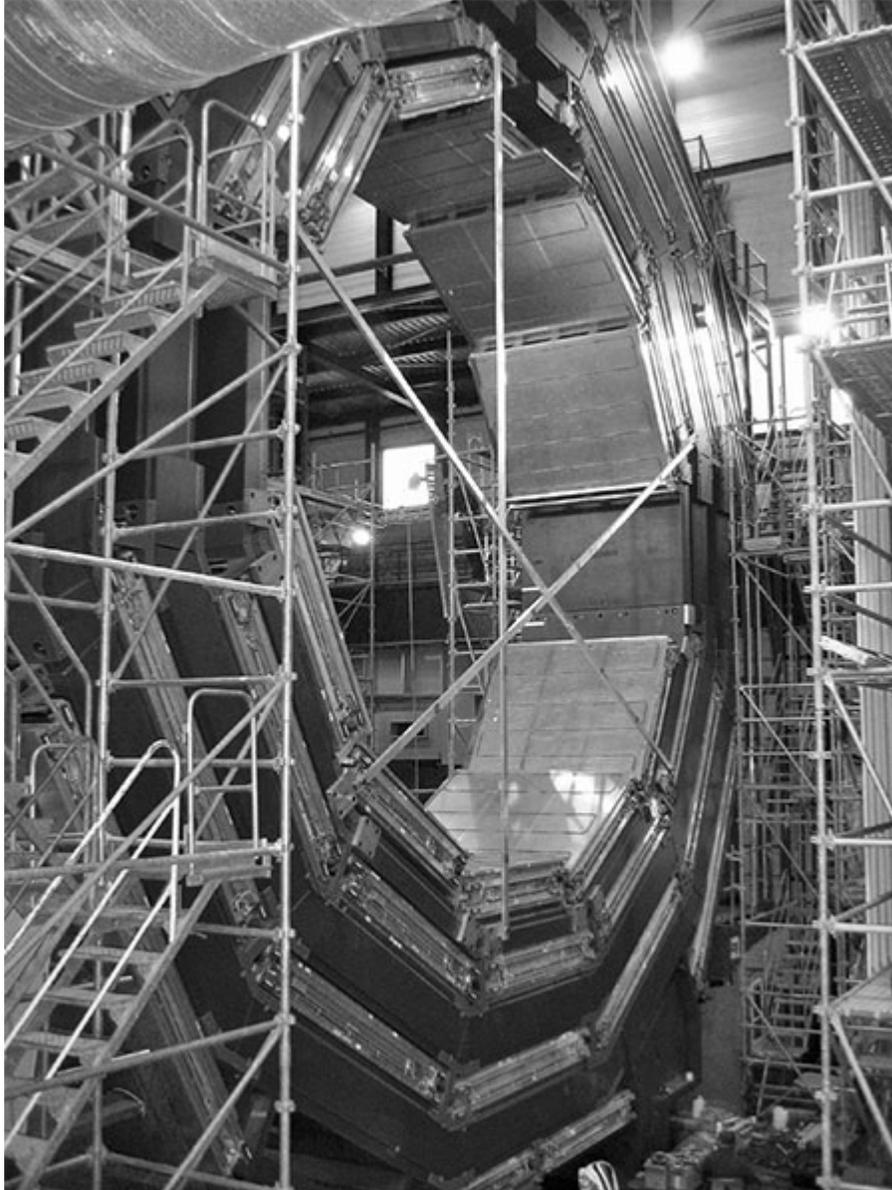
*Figura 38. A bobina magnética de retorno do CMS entrelaçada com seu detector de múons (ambos em construção).*
