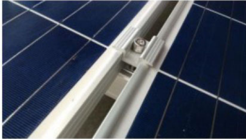
Figura 31 - aplicação grampo intermediário
