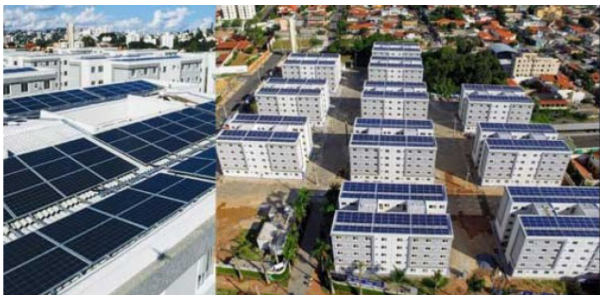
Figura 6 - Sistemas instalados em áreas comuns(terraços) de condomínios
