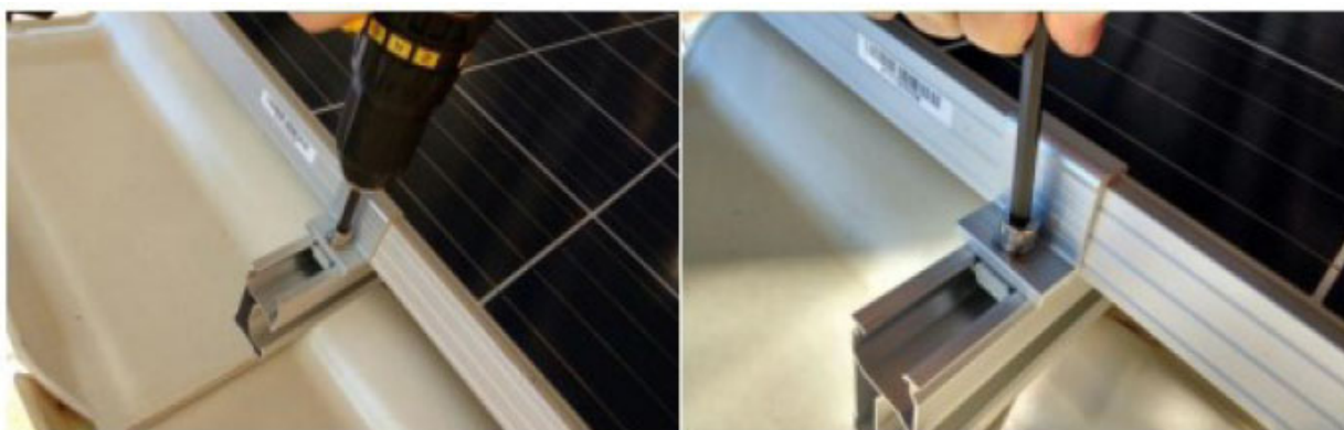
Figura 23 - Fixação utilizando chave allen 6 mm (parafusadeira e manual)
