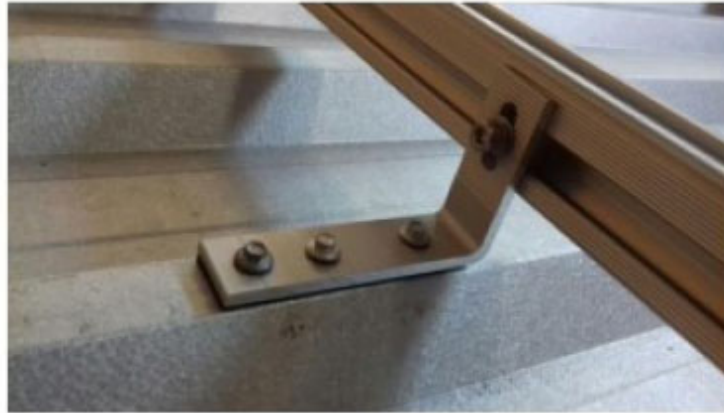
Figura 27 - fixação do suporte para telha metálica
