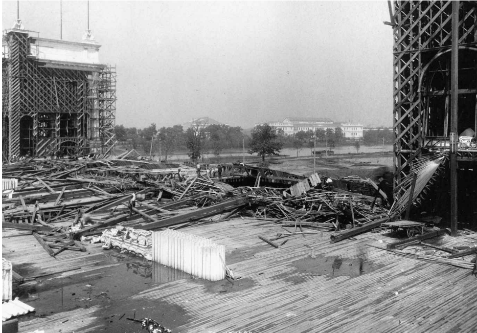
Edifício das Manufaturas e das Artes Liberais, depois da tempestade de 13 de junho de 1892.
