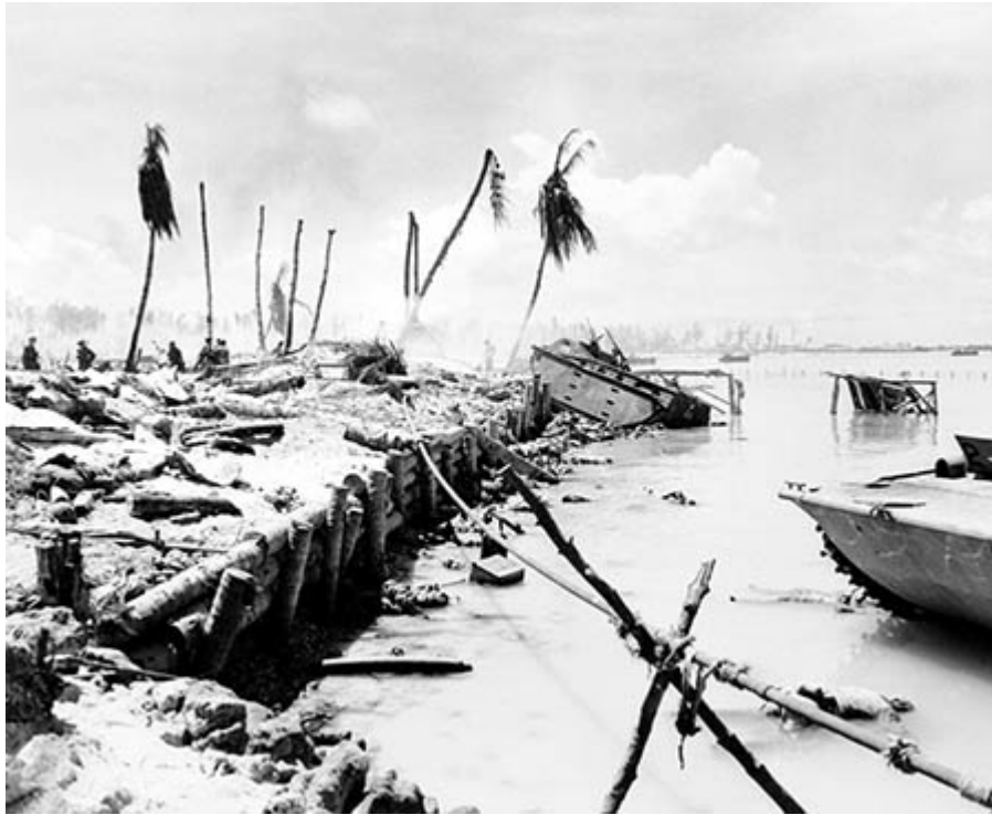
7. A orla de Betio no atol de Tarawa, nas ilhas Gilbert, em 1947, deixa claro como as trincheiras instaladas no mar frustraram a ofensiva dos veículos anfíbios americanos.
