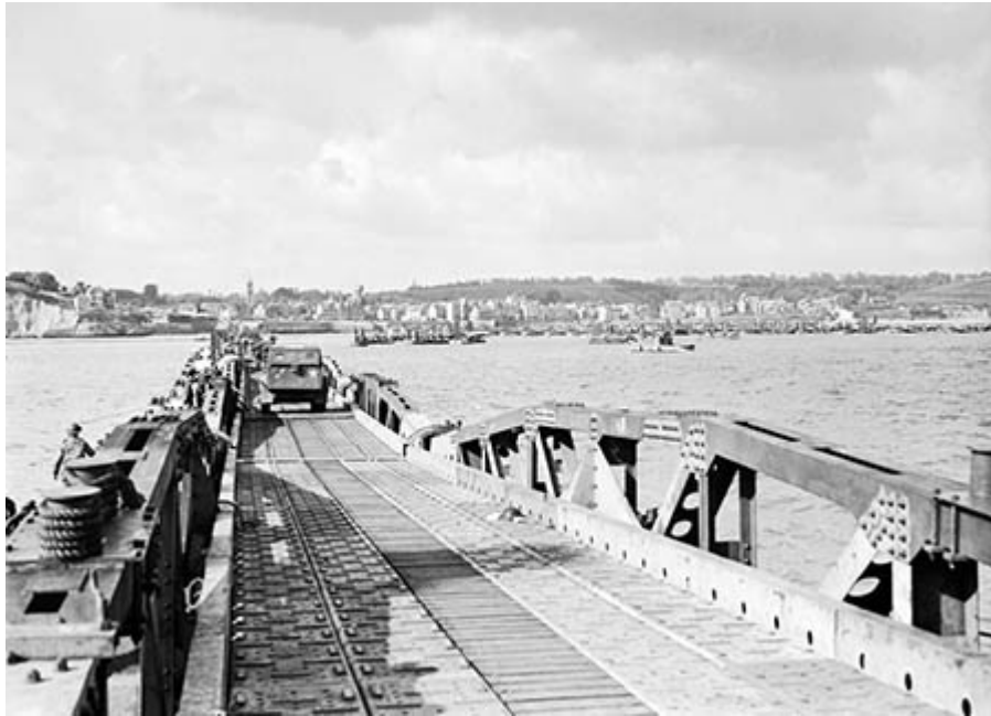
41. O porto Mulberry em Arromanches, com caminhões carregados de suprimentos, em junho de 1944. Os portos desmontáveis Mulberry foram construídos pelos Seabees no porto de Pembroke, rebocados em seções até as praias da Normandia e em seguida reagrupados para ajudar as tropas de invasão.
