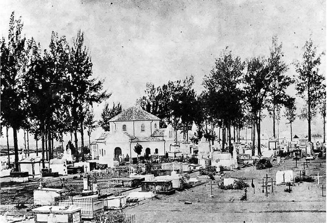
49. Cemitério da Consolação no final do século XIX. Ao fundo, a capela original cuja construção foi custeada pela doação da marquesa de Santos
