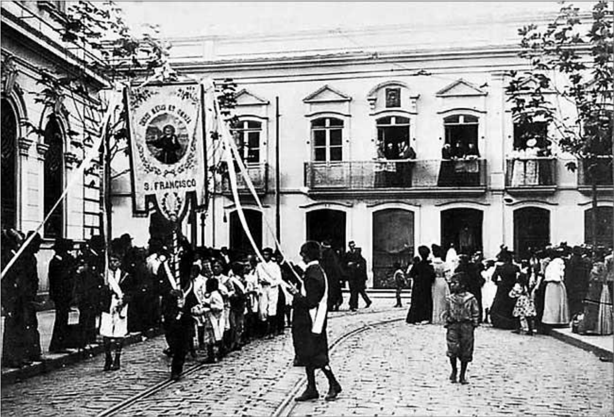
55. Antigo solar de Domitila transformado em Palácio Episcopal. Procissão de São Francisco, em 1909
