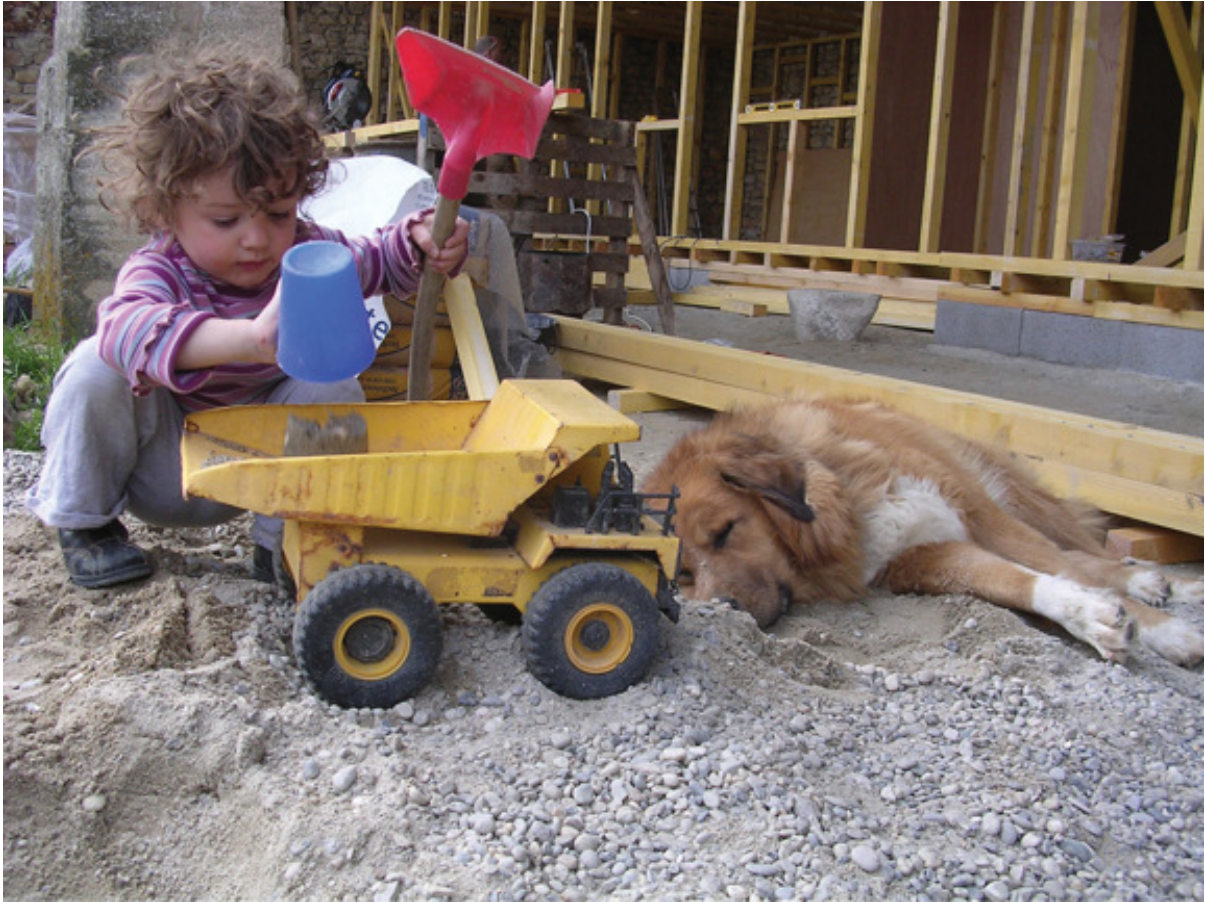
Um canteiro de obras em um canteiro de obras.
