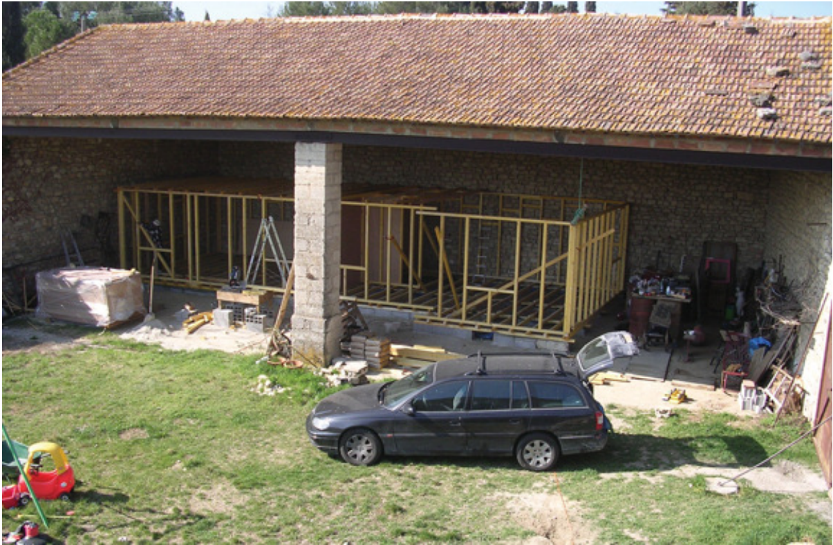
A nova casa toma forma.
