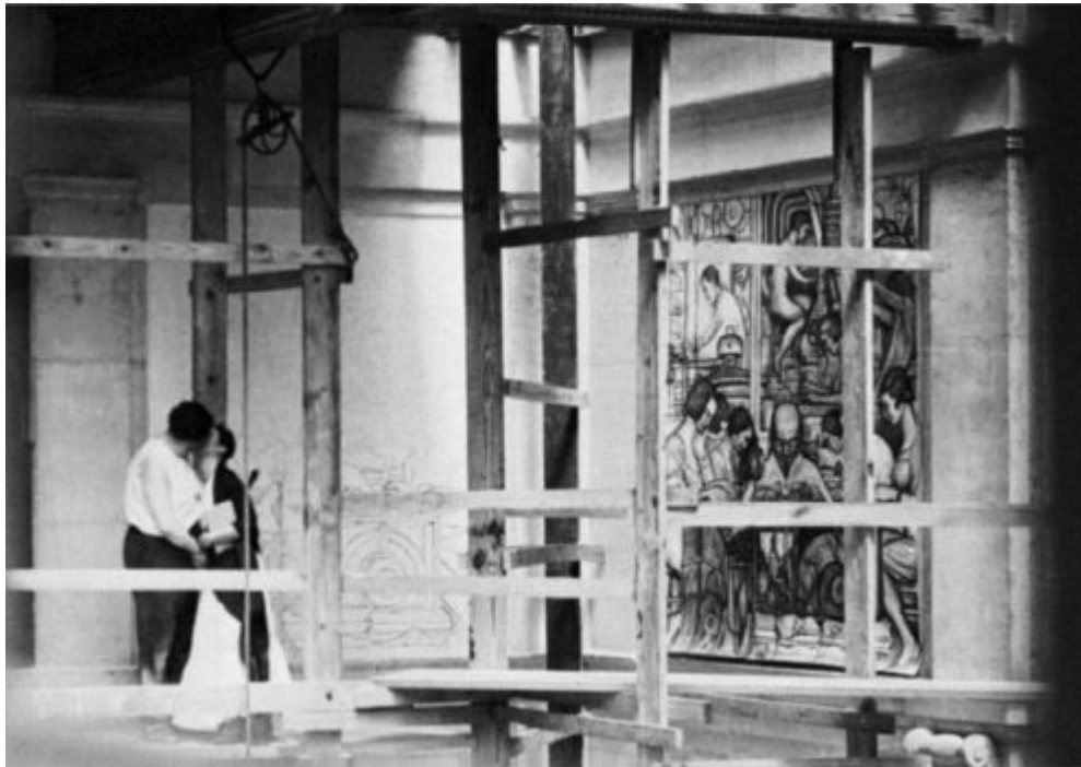
24. No andaime do Instituto de Artes de Detroit, 1932.
