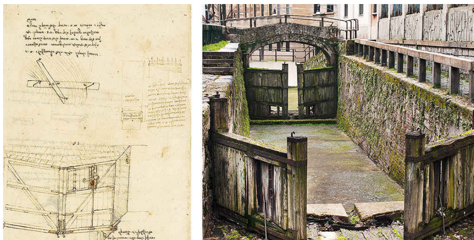
O esboço de Da Vinci para as comportas de um canal e comportas em Milão construídas segundo seu projeto
