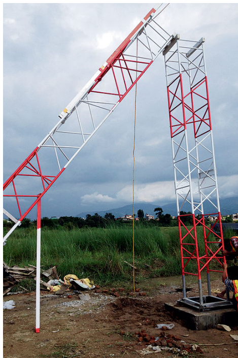
Torre frangível, da Ercon
