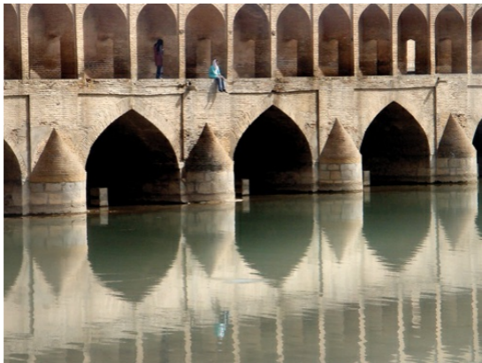
Com 21 arcos, a Ponte Djubi, em Estáhan, estende-se por 147 metros sobre o rio Zâyandeh.
