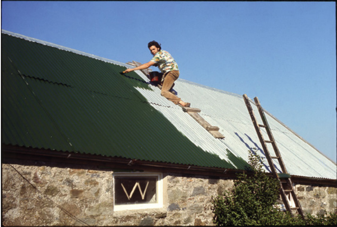
Pintando o telhado na fazenda. Escócia, 1971
