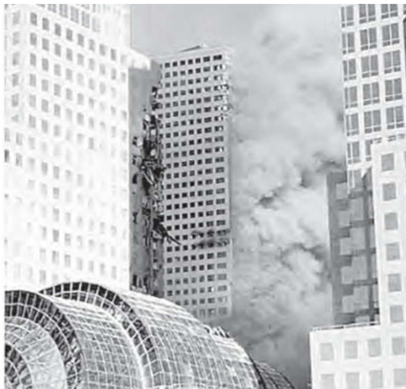
d. O WTC7 visto pelo lado sudoeste, mostrando a verdadeira extensão do incêndio e do dano estrutural. FOTO POR CORTESIA DO FEMA: www.fema.gov/pdf/library/fema403_ch5.pdf .
