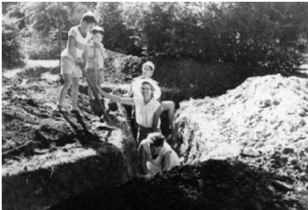
Cavando trincheiras em Gan Shmuel.
